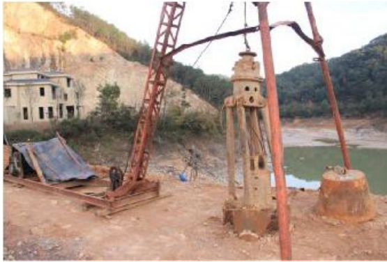
Hình 9. Khoan tạo giếng tạo cọc đất
